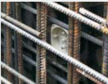
Capacul KBV fixat pe cofraj.
