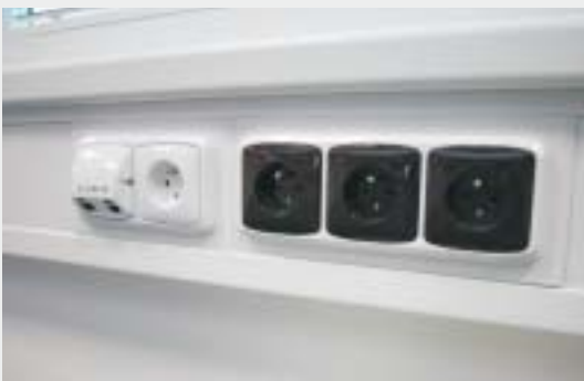
Exemplu de montaj al canalului de parapet PK 140X70 D.
