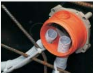
Tuburi flexibile montate în corpul KBT.
